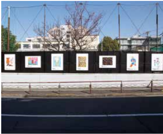
第15号 京都市立北総合支援学校 中央分校整備工事
